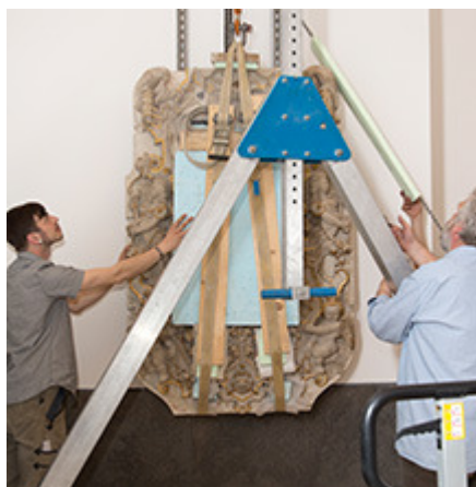
Montage eines Sandstein-Epitaphs
